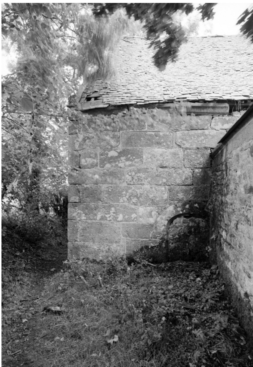
Vue du mur ouest du bras nord du transept
