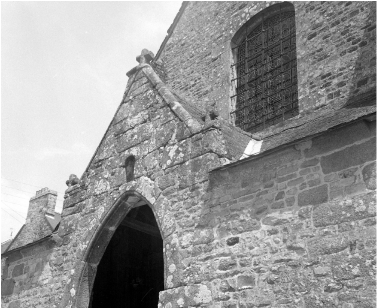
Etat en 1971, détail du porche ouest
