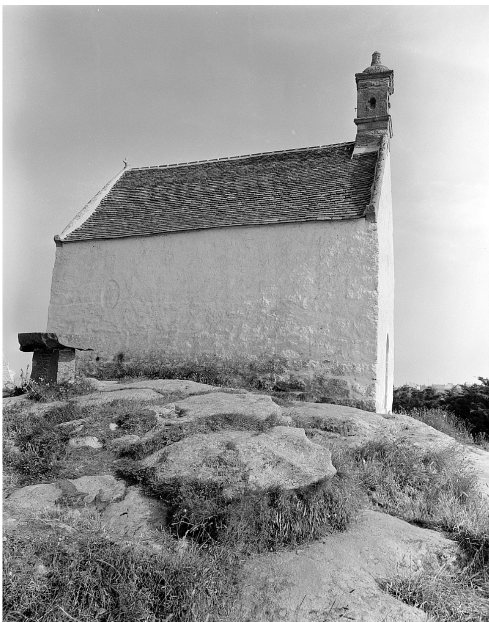
Vue générale nord
