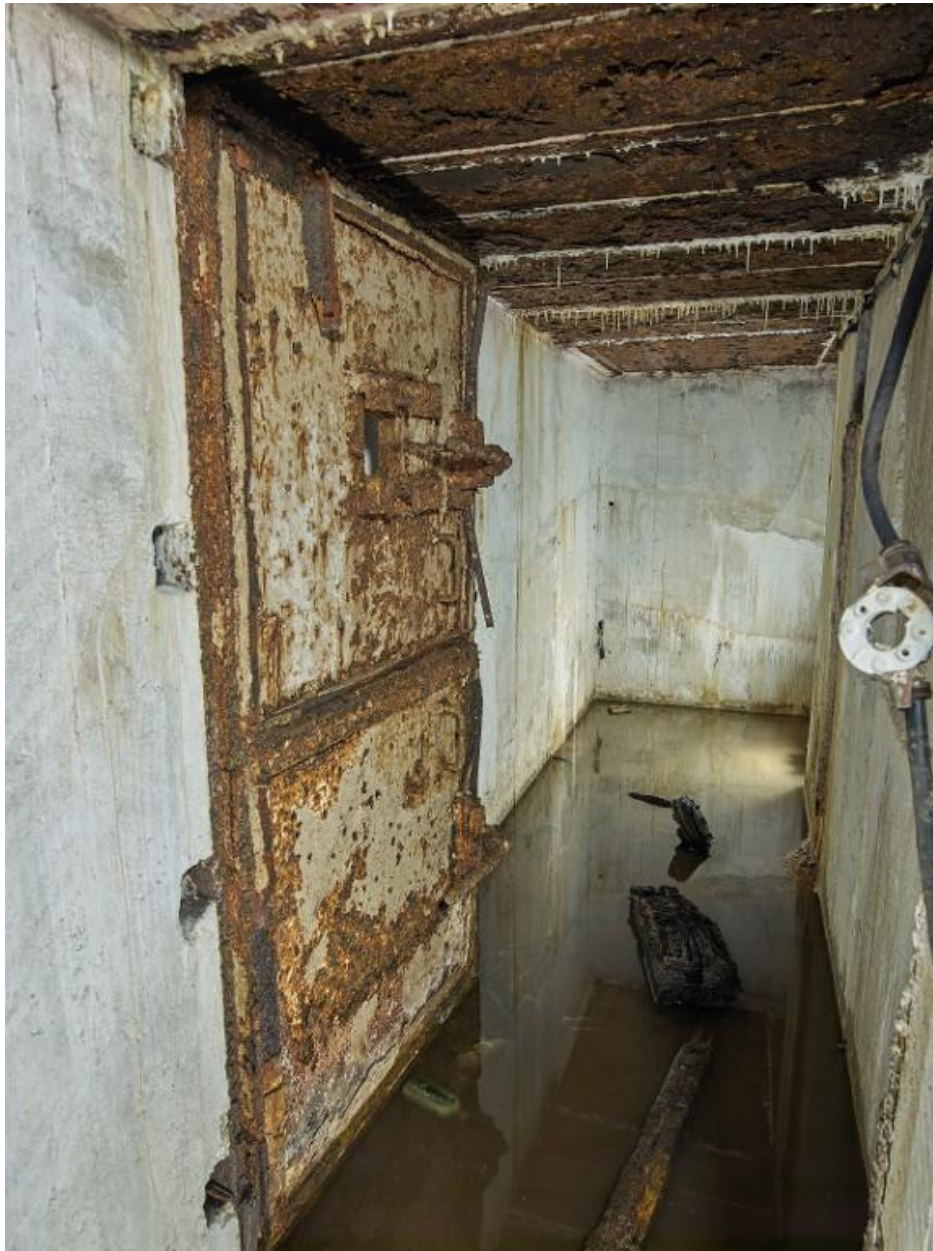
Vue du couloir d'accès de la chambre de combat nord-ouest : porte blindée à deux vantaux. La chambre de combat nord-ouest est partiellement inondée
