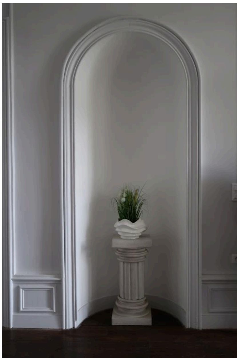
Lambris, du rez-de-chaussée, détail
