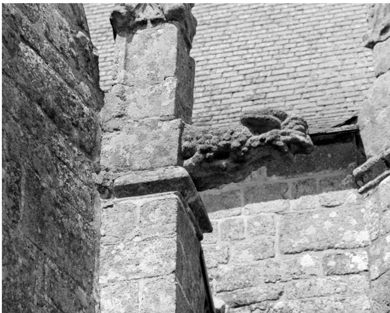
Elévation sud, vue de détail de gargouille.
