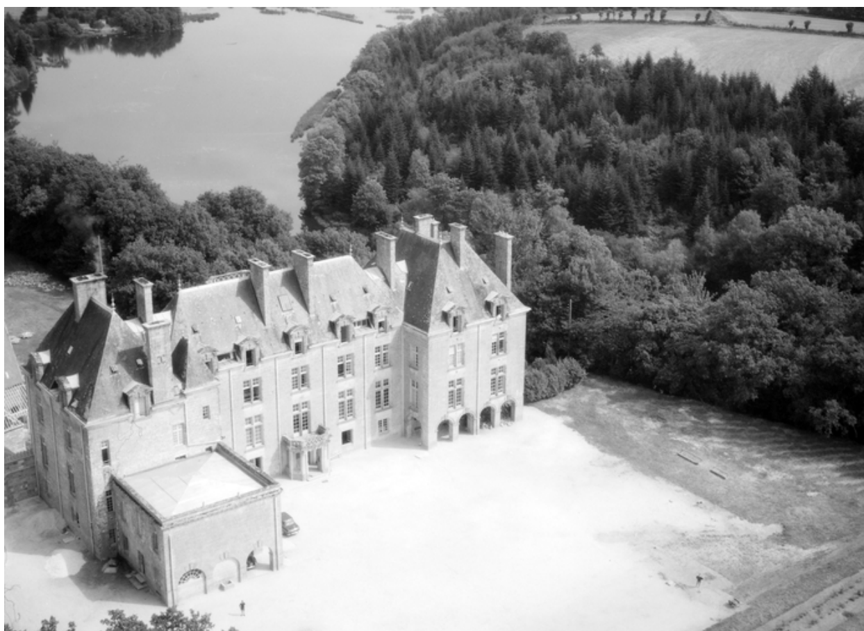
Vue aérienne, face sud-ouest
