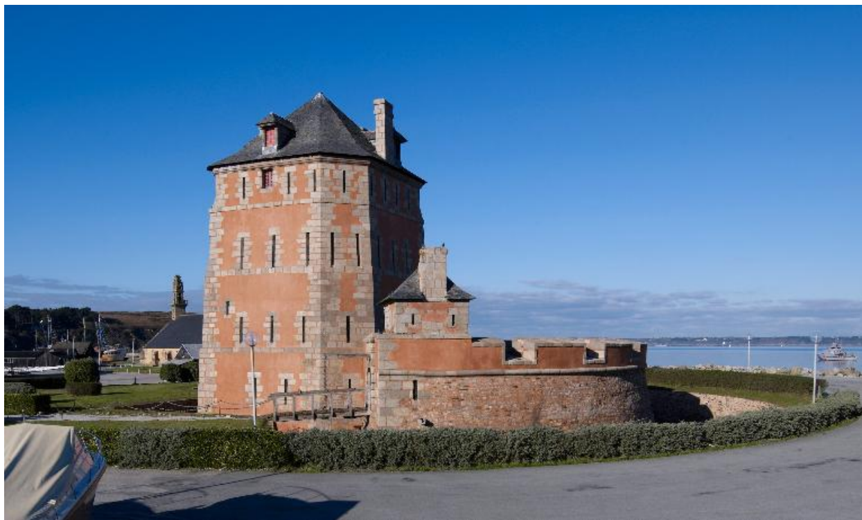
Camaret-sur-Mer : vue de la tour Vauban
