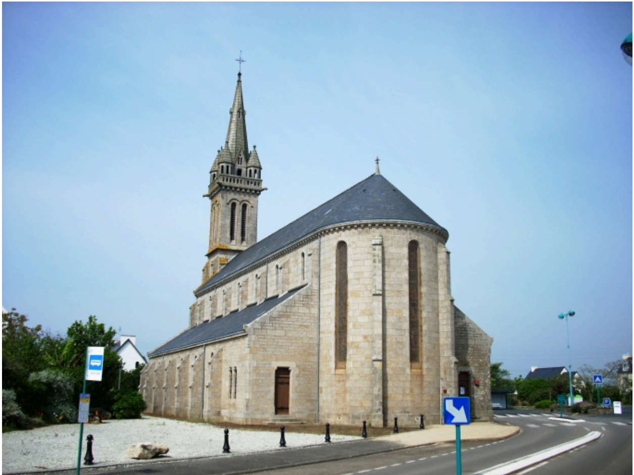
Tréffiagat, église paroissiale Saint-Riagat : vue générale sud-est
