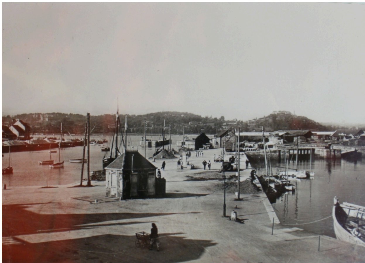
Vue de la bascule au 1er plan et de la capitainerie à l'extrémité du Quai Neuf, avec les annexes des Ponts-et-Chaussées, vers 1950 (carte postale, collection particulière)
