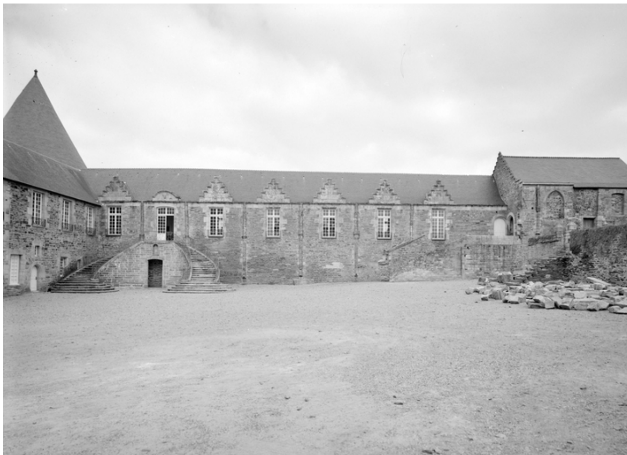
Aile nord, élévation sur cour.
