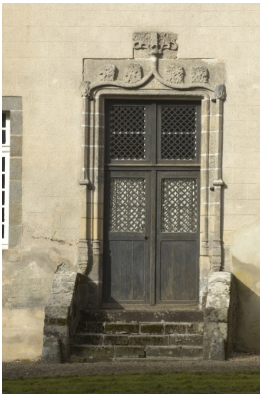
Logis, façade antérieure, détail, porte
