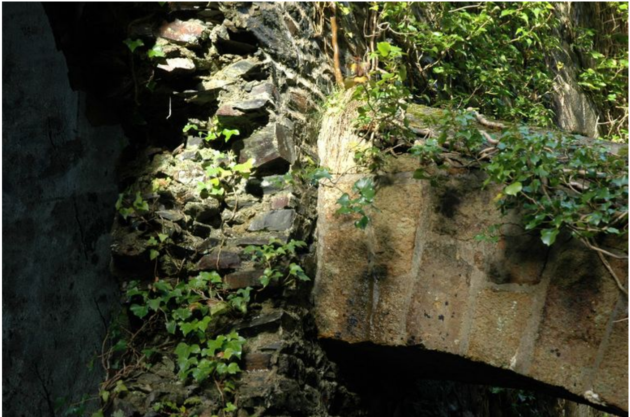
Vue de la caserne défensive Robert : façade postérieure, arc-boutant
