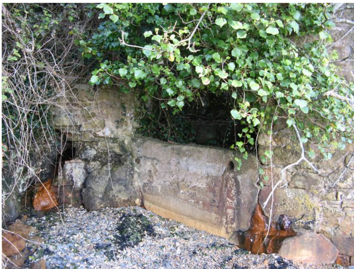
Source actuelle et bassin de la fontaine de Quéléren
