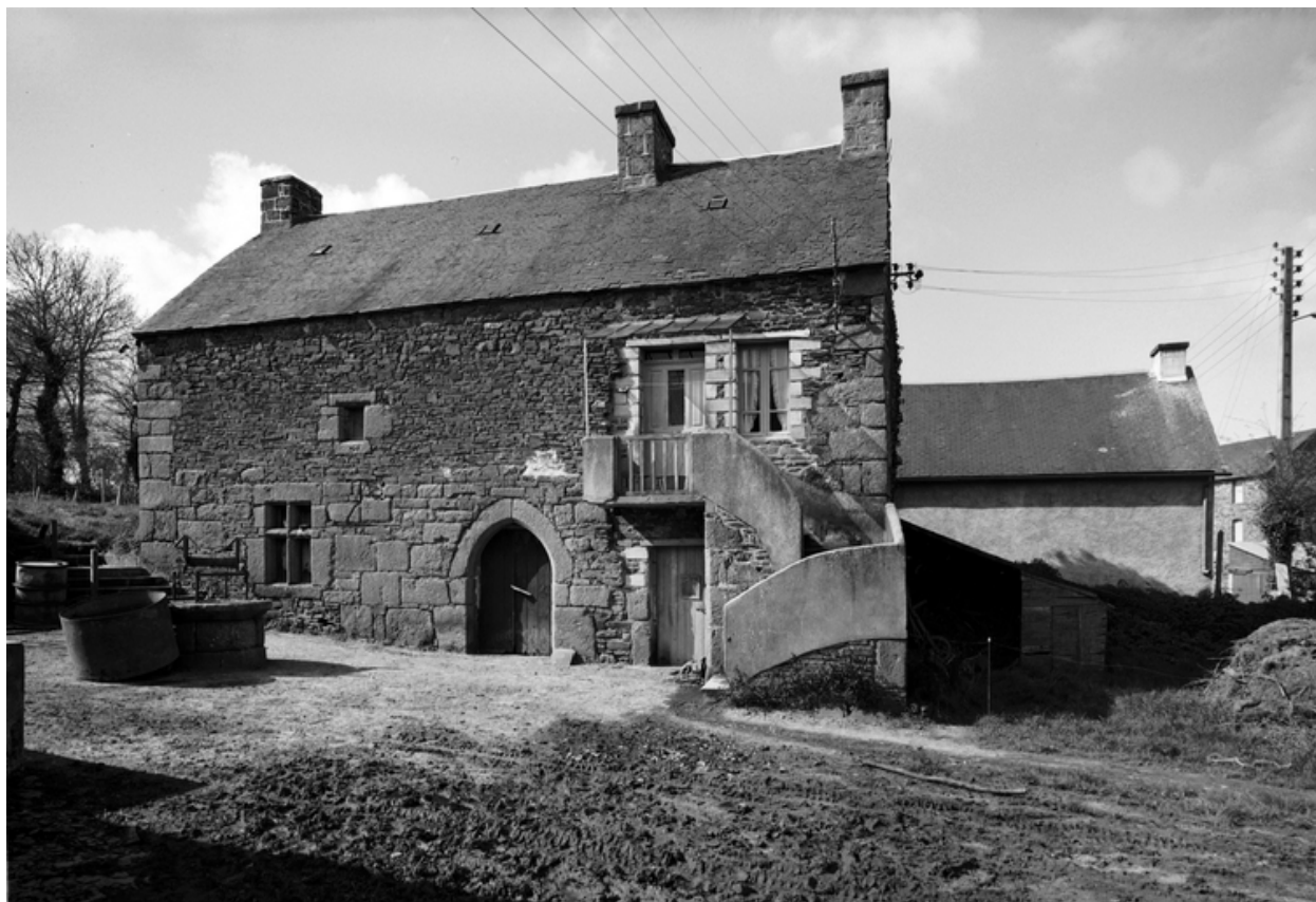
Vue générale de la façade est
