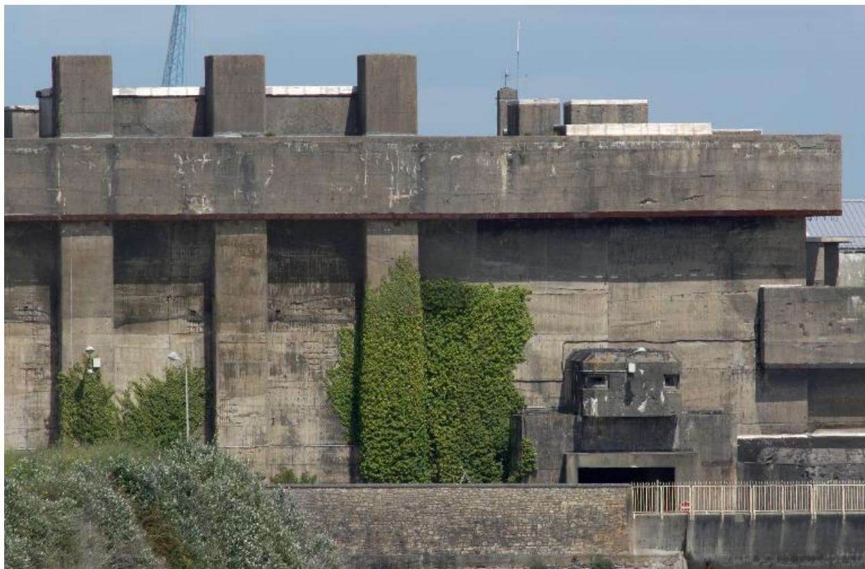
Vue de la base de sous-marins : détail du front sud-ouest, entrée ouest et dalle de couverture
