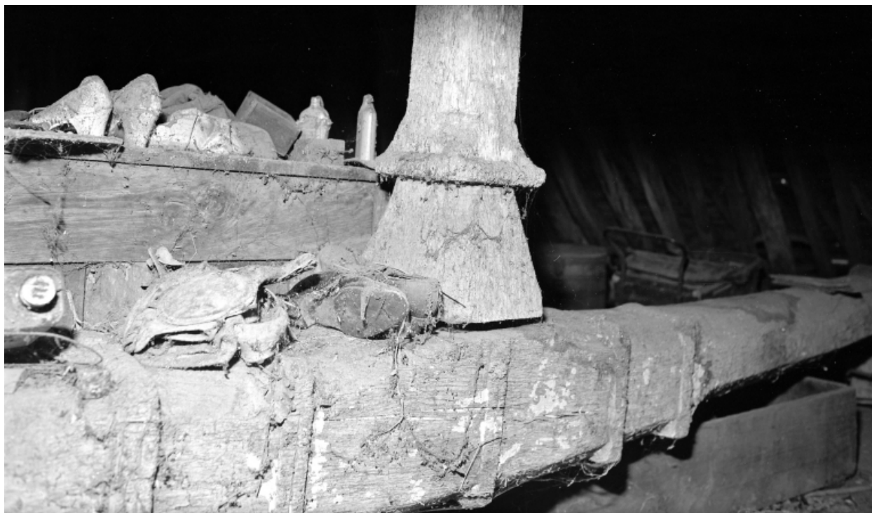
Détail de charpente.
