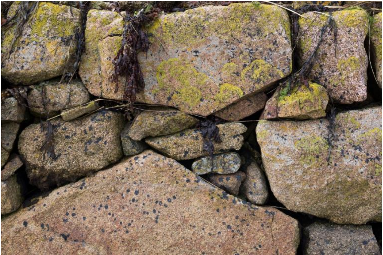
Détail de moellons insérés dans des blocs de granite du mur de soutènement sur la rive ouest de l'anse de Pelinec
