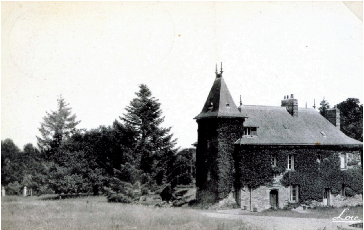
Carte postale ancienne présentant une vue sud-ouest du manoir de l'Hermitage
