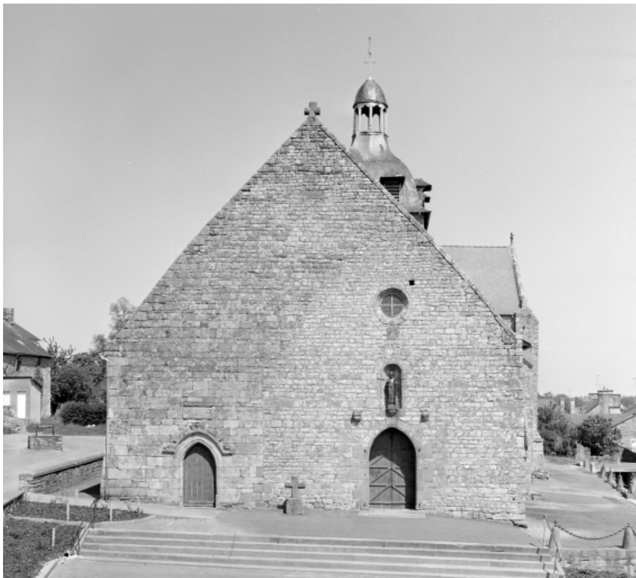
Elévation ouest, porte principale : vue générale
