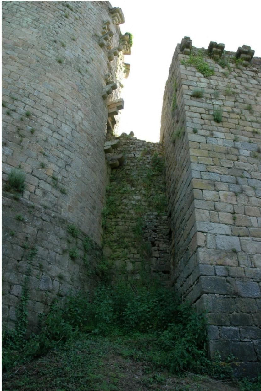
Vue du petit pan de courtine situé entre la tour d'Acigné (à gauche) et le logis (à droite) : elle est en maçonnerie de moellon. Les consoles des trois latrines en encorbellement de la tour subsistent ; au sommet de la tour se voient des mâchicoulis de type breton
