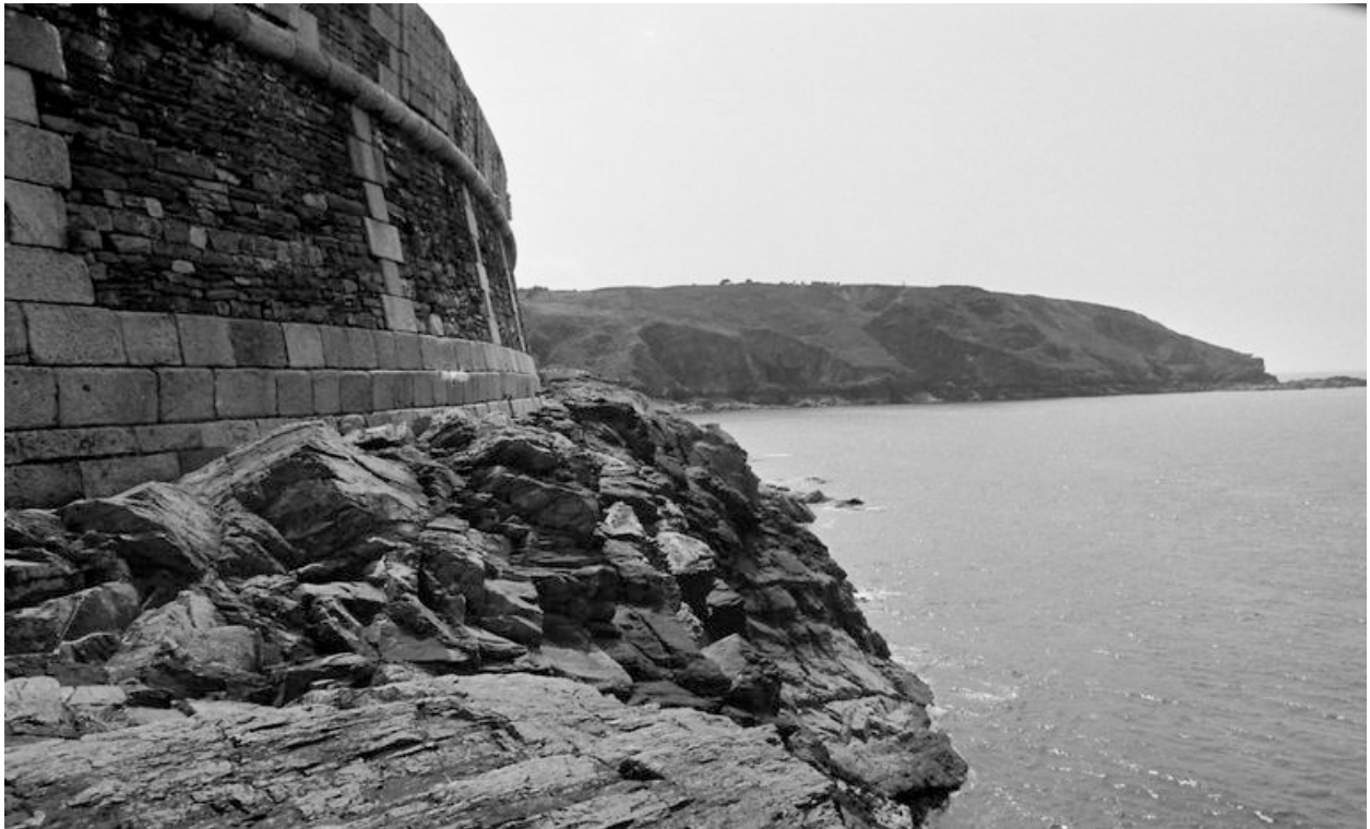
Vue de la batterie de Cornouaille en 1967 : escarpe, chaînes harpées en pierres de taille de granite
