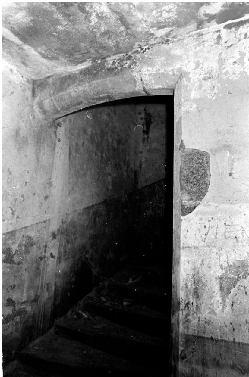
Vue du fort : cage d'escalier (état en 1969)
