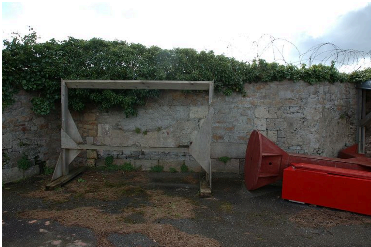
Vue de la batterie haute du Mengant : piedroits, embrasure murée
