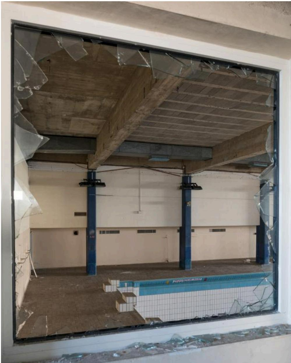
Vue sur le bassin de la piscine et la structure poteaux poutres en béton armé (Jean de Jaegher et François Rousseau, architectes, 1968). Noter la profondeur du bassin, du côté des plots : 3m40.
