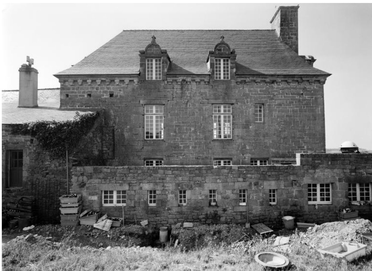
Vue d'ensemble de la façade nord
