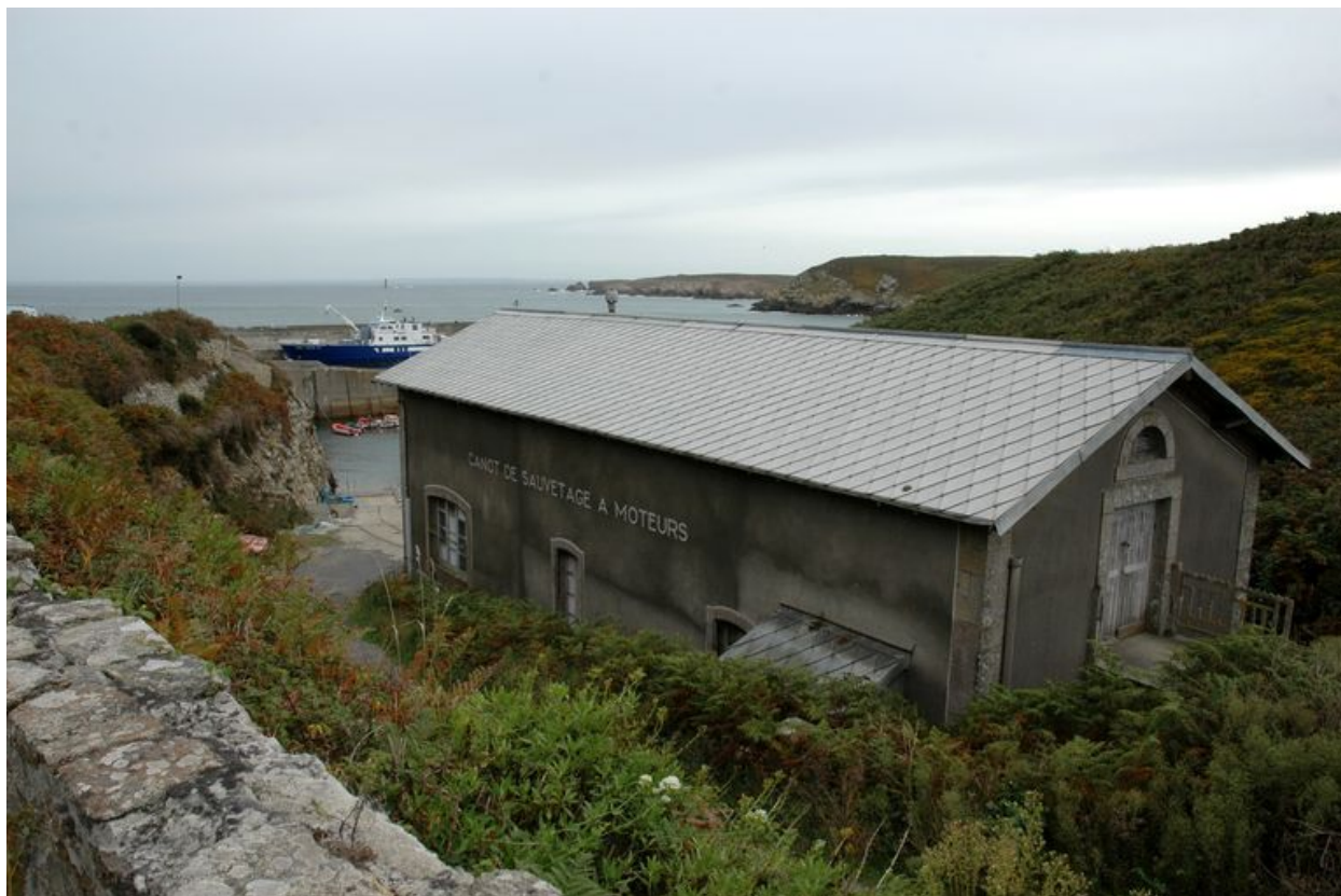
Vue du port-abri du Stiff, la station de sauvetage
