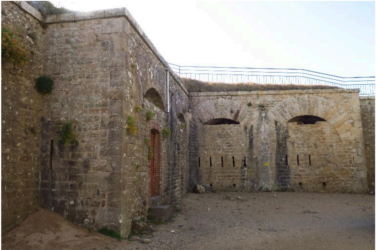
Saint-Pierre-Quiberon, fort de Penthièvre, enceinte, casemates à feux de revers du fossé.
