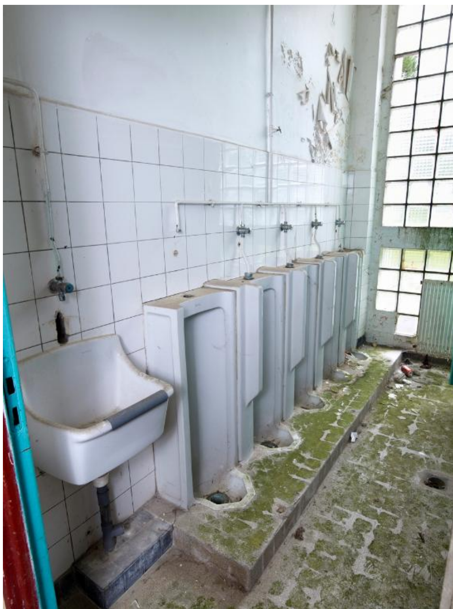
Bloc WC, internat de garçons (1954), désaffecté.
