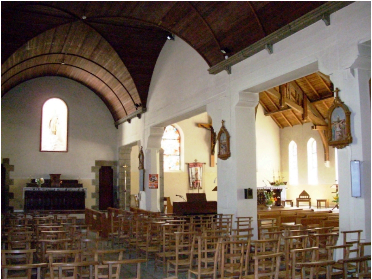
Ploudalmézeau, église de Portsall : vue transversale de la chapelle latérale nord vers le sud-est
