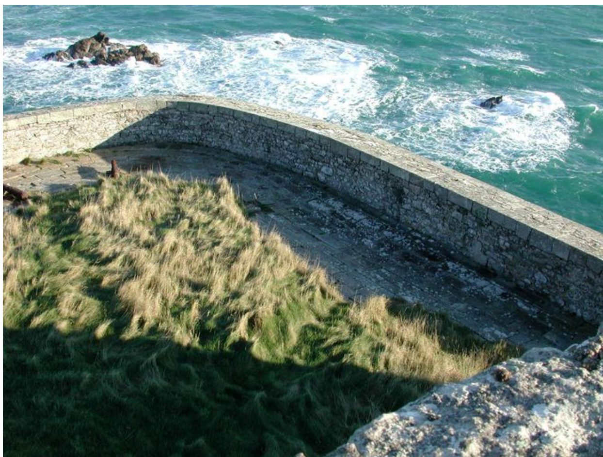
Vue du Fort La Latte
