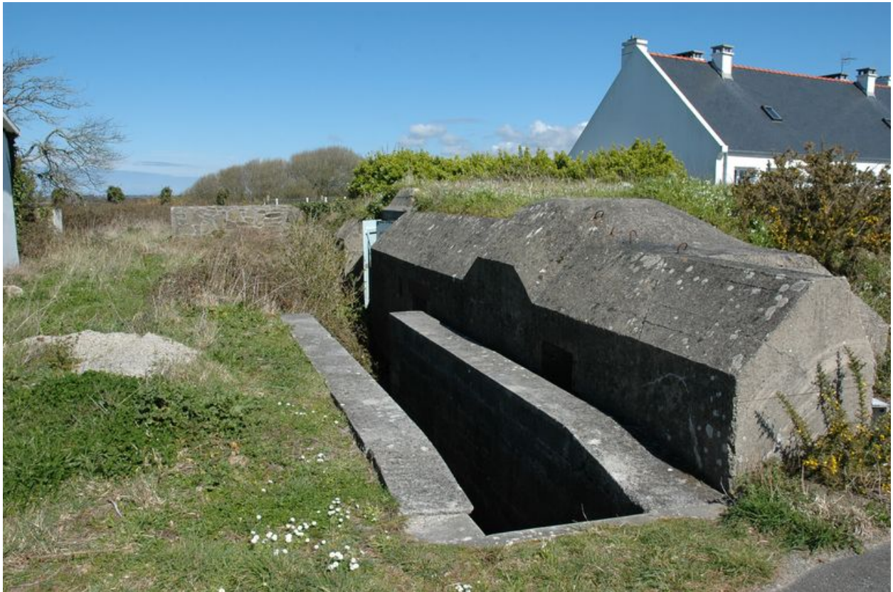
Vue de l'ensemble fortifié de la pointe du Renard : abri de type 601 pour canon antichars avec toit blindé
