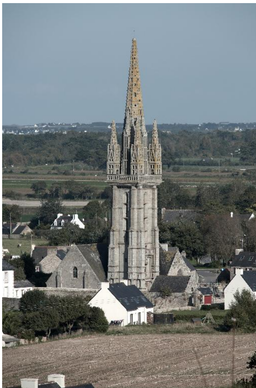
Vue de situation de l'église
