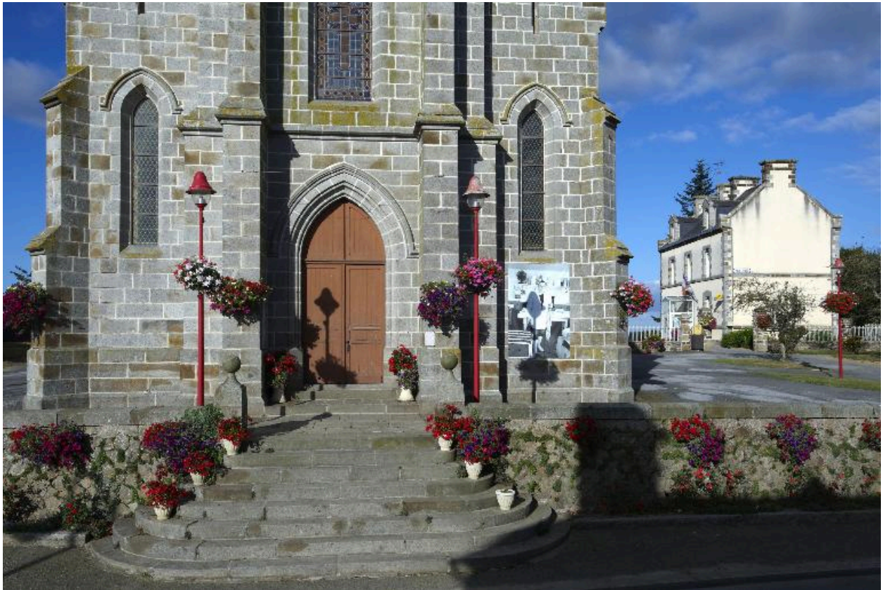
Détail de la façade
