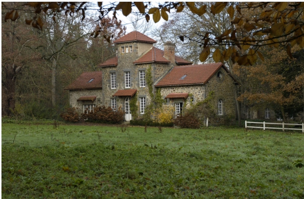
Atelier de peinture et communs : vue générale ouest
