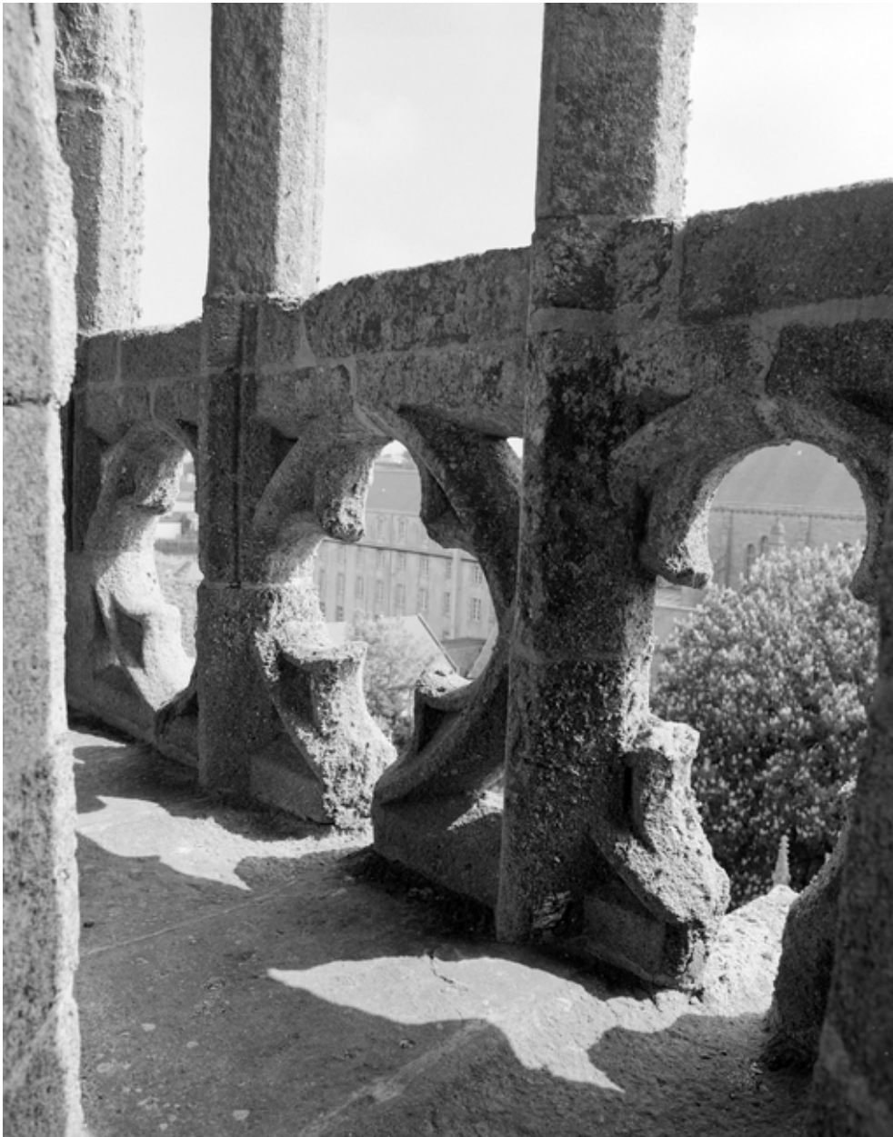
Détail de la balustrade trilobée
