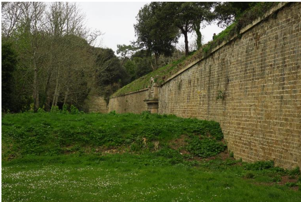
Le Palais, enceinte urbaine, courtine 20-21.
