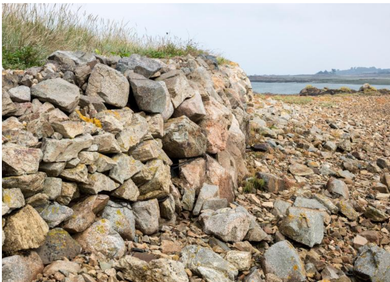
Vue d'un mur en pierre sèche prolongé par un enrochement au niveau de la façade sud du Palud
