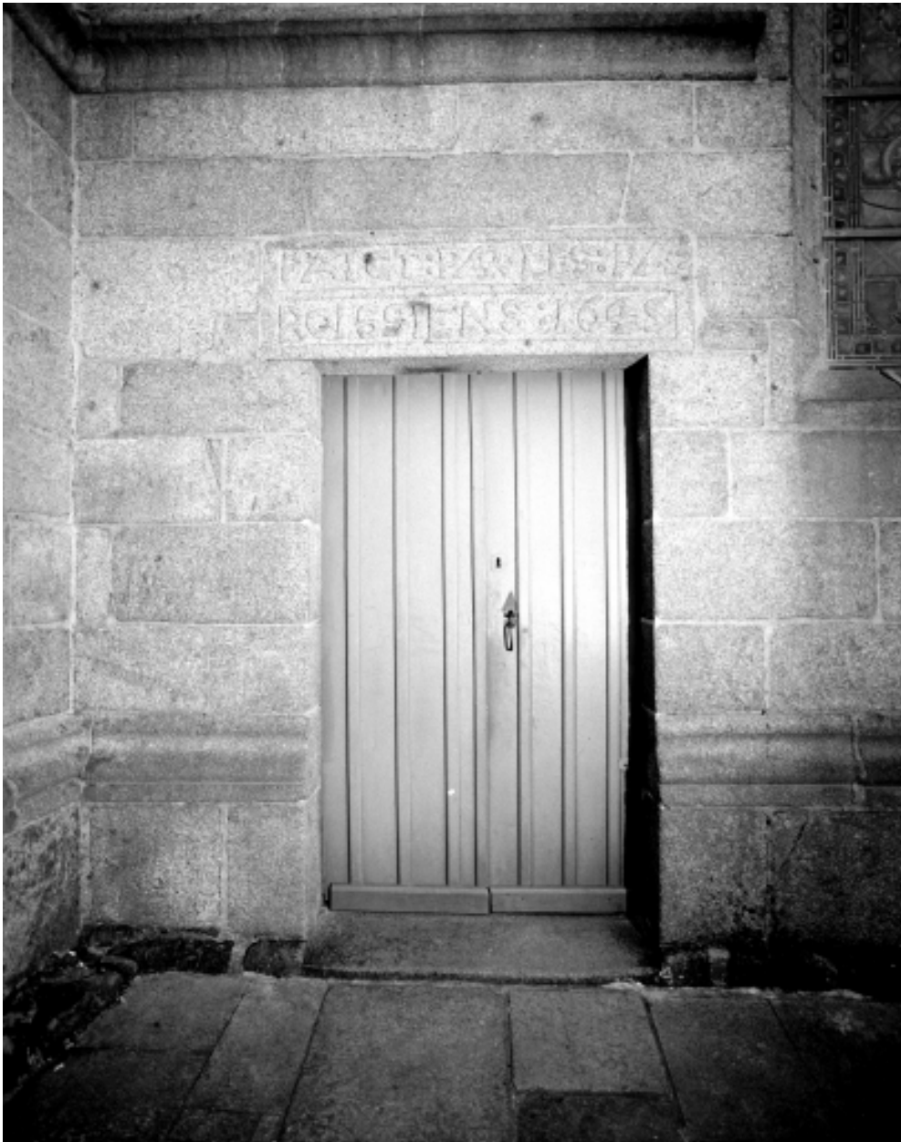
Elévation Nord, porte Ouest : vue générale
