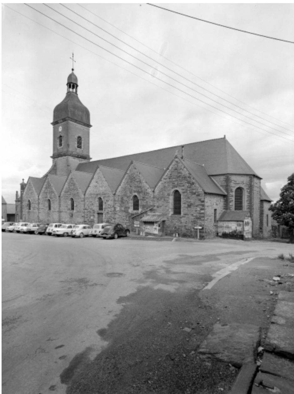
Elévation sud : vue générale
