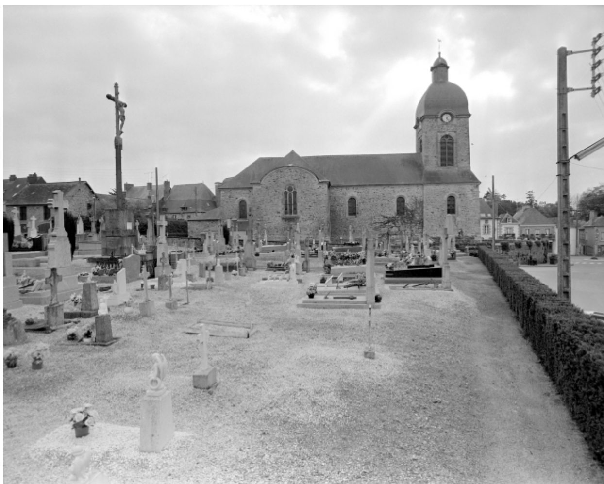
Vue générale nord
