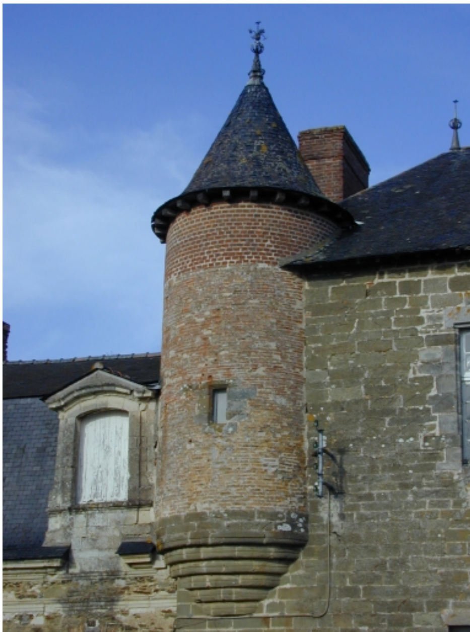
Détail de l'une des tourelles en encorbellement
