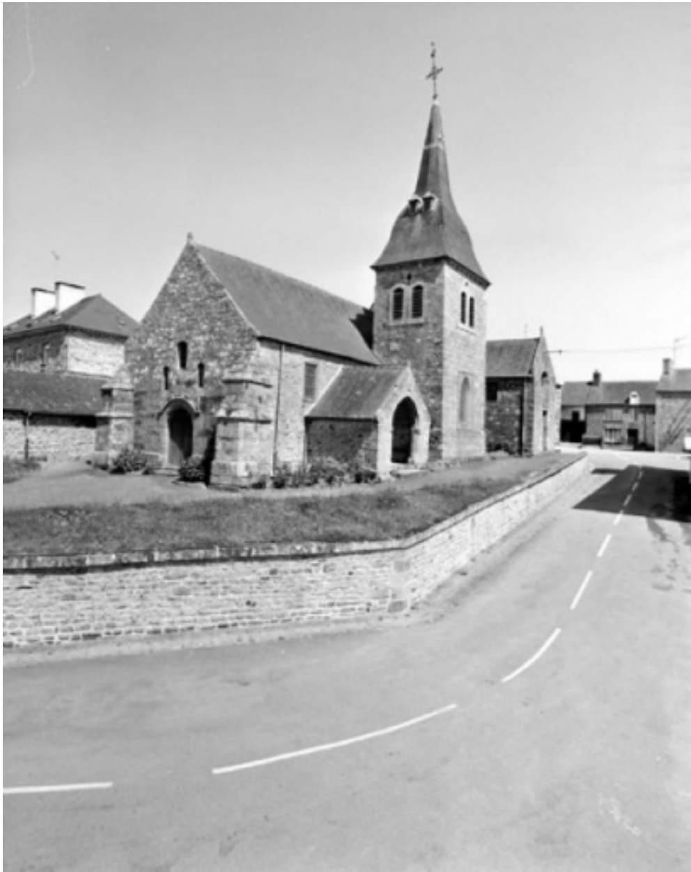
Elévation Sud-Ouest : vue générale
