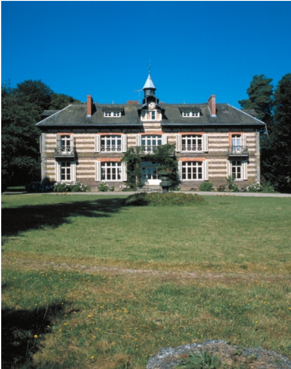
Vue générale est
