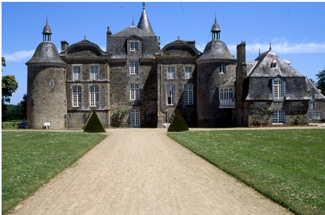
Vue générale ouest
