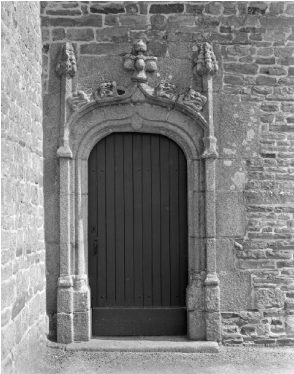
Elévation Sud, porte Est : vue générale
