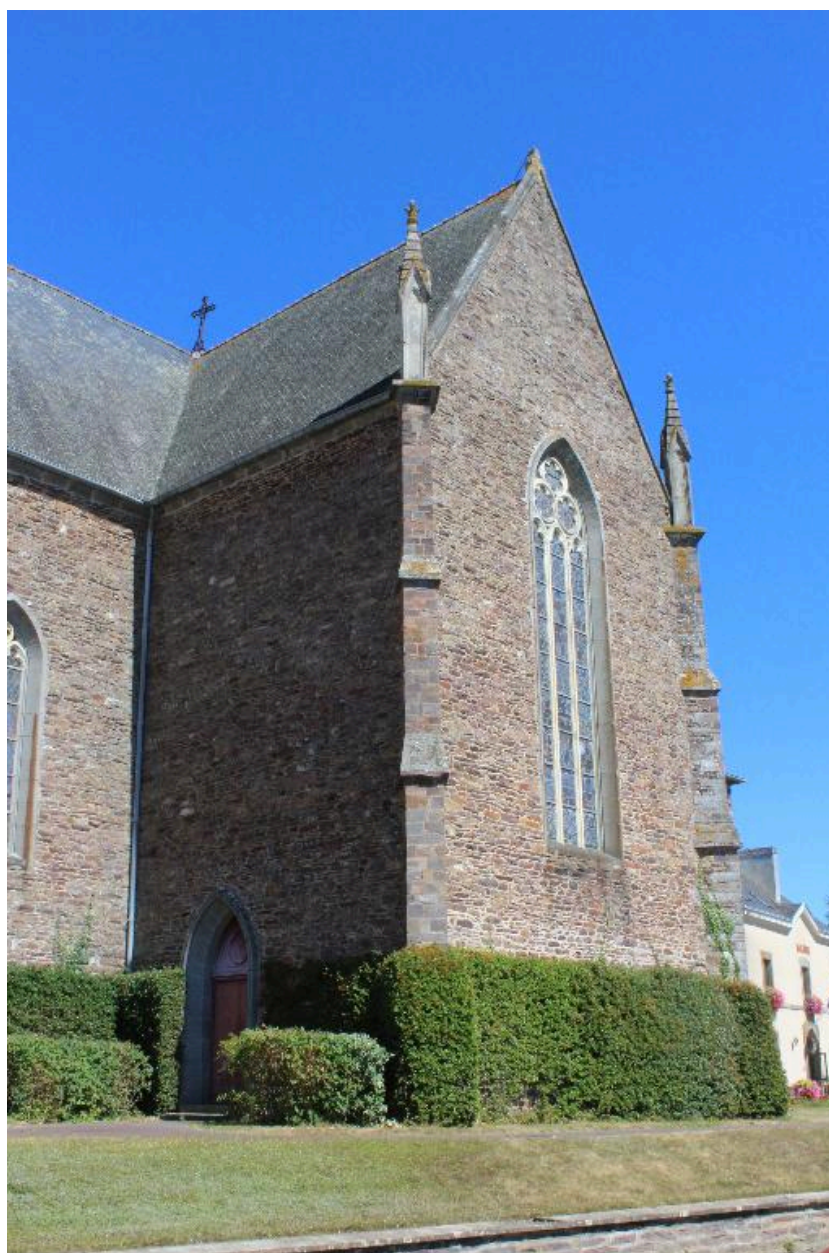
Bras sud du transept : vue générale
