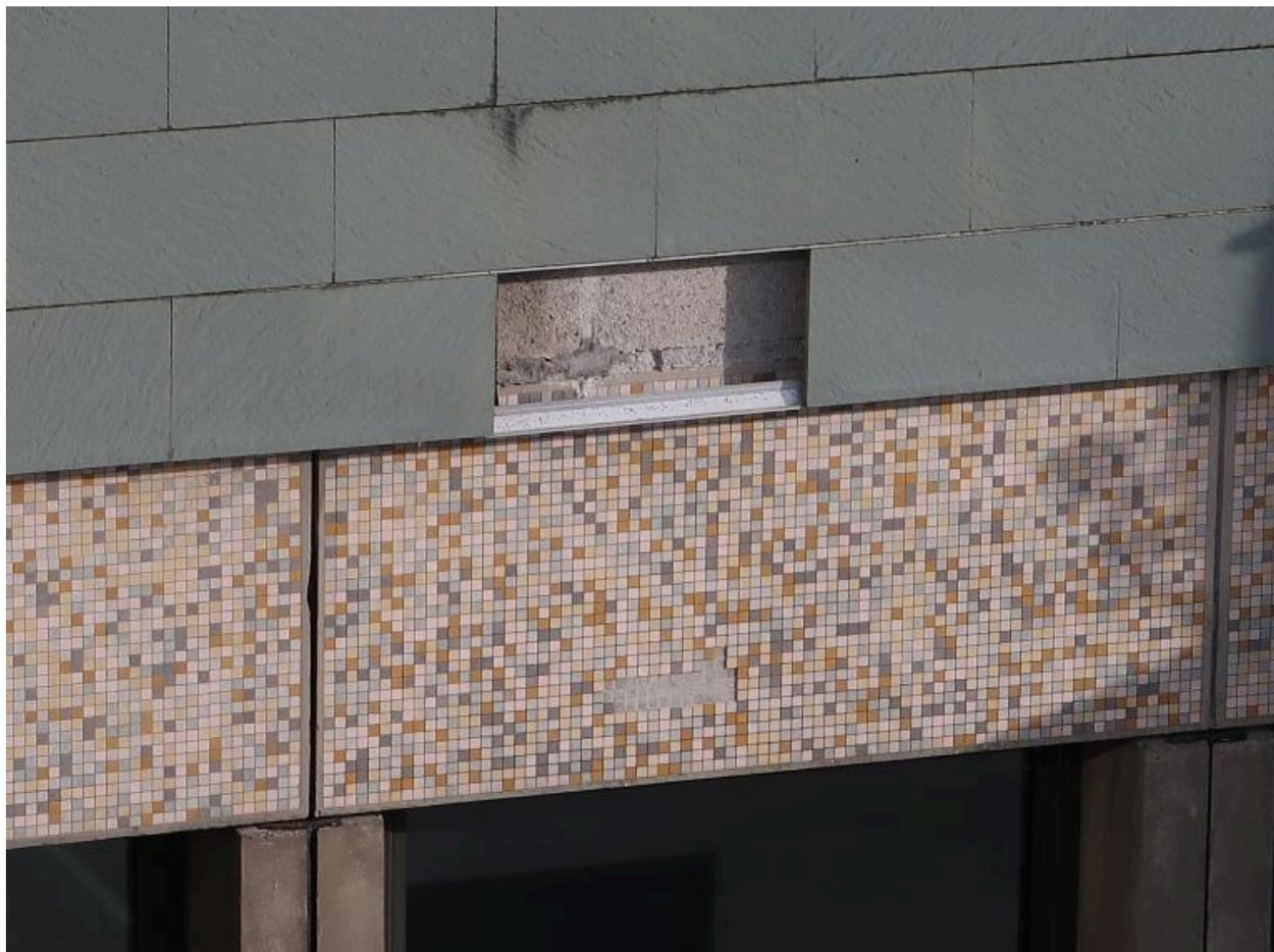
Dans le patio : détail sur la surélévation de 1986 et les deux types de parement des façades.
