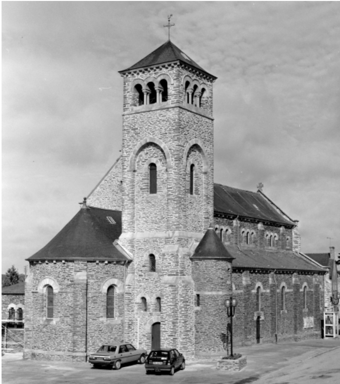
Elévation est : vue générale
