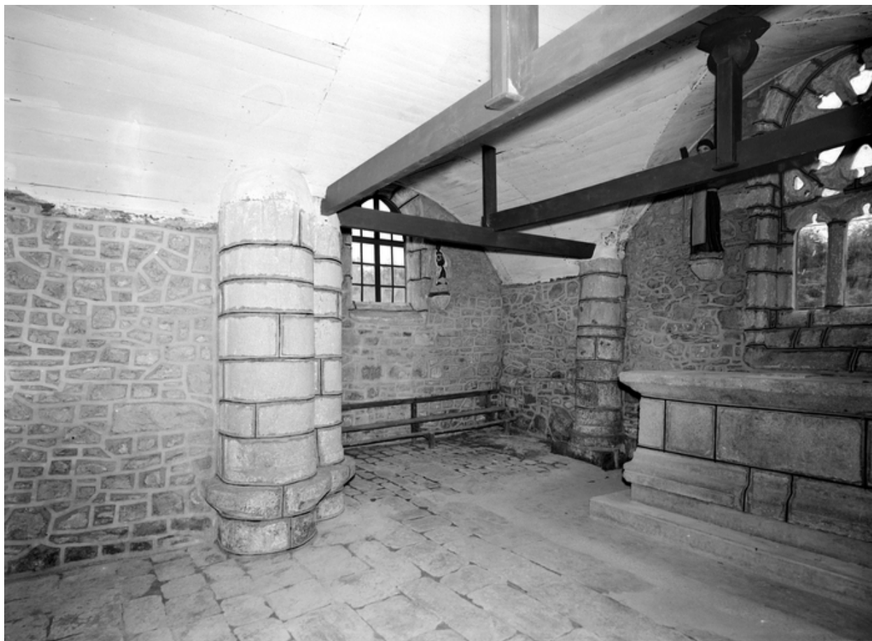
Bras nord du transept : vue diagonale
